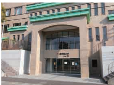
若木21エントランス
