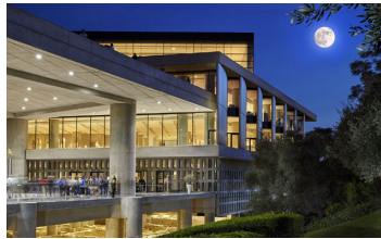
エントランス外観（TO BHMA, Aug. 16, 2024）
