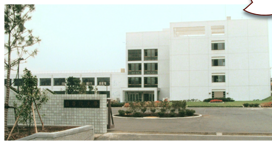
昭和60年に建設された校舎
